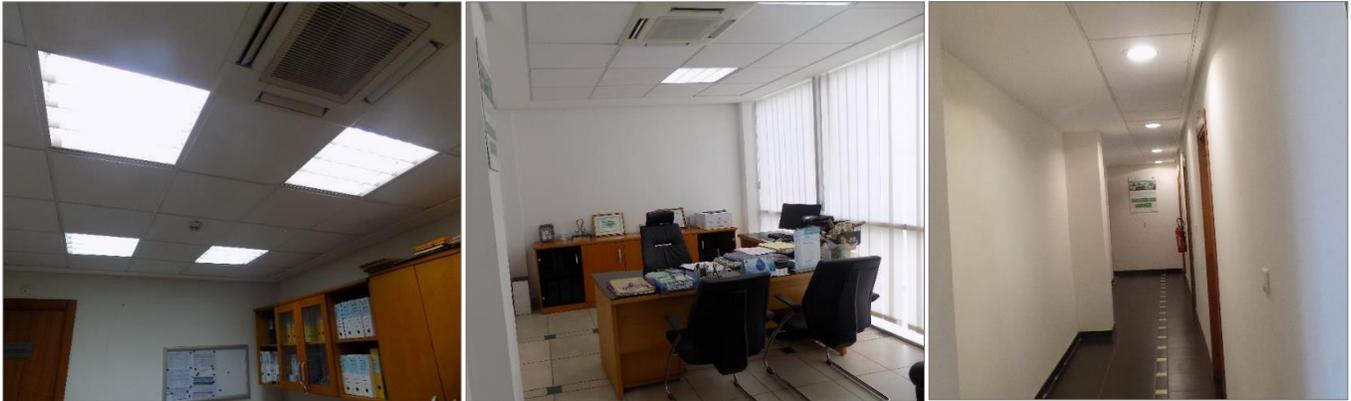
Figure 5 : Panneau plafonnier d'éclairage, cassette plafonnière, lampe incrustée dans le plafond (de gauche à droite).
