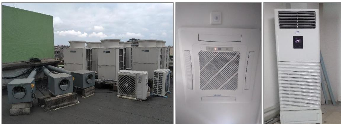
Figure 9 : Unités extérieures du DRV, split et extracteur – cassette plafonnrière du DRV – armoire de climatisation.
