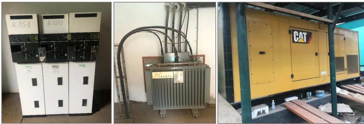
Figure 3 : Cellules SM6, Transformateur NEXANS et groupe électrogène CAT.
