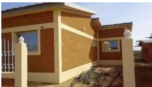
Figure 9 : Maison construite en BTC
