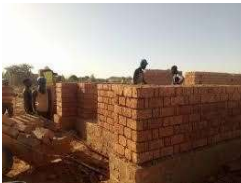
Figure 8 : construction en adobe
