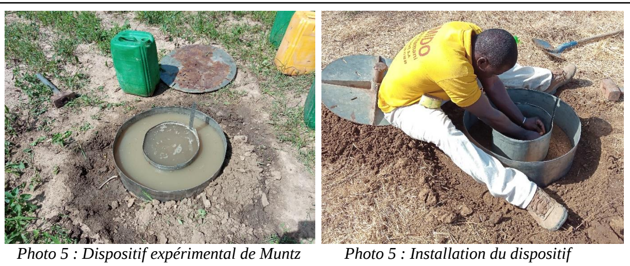
Figure 4 : Images prises lors des mesures d'infiltration
