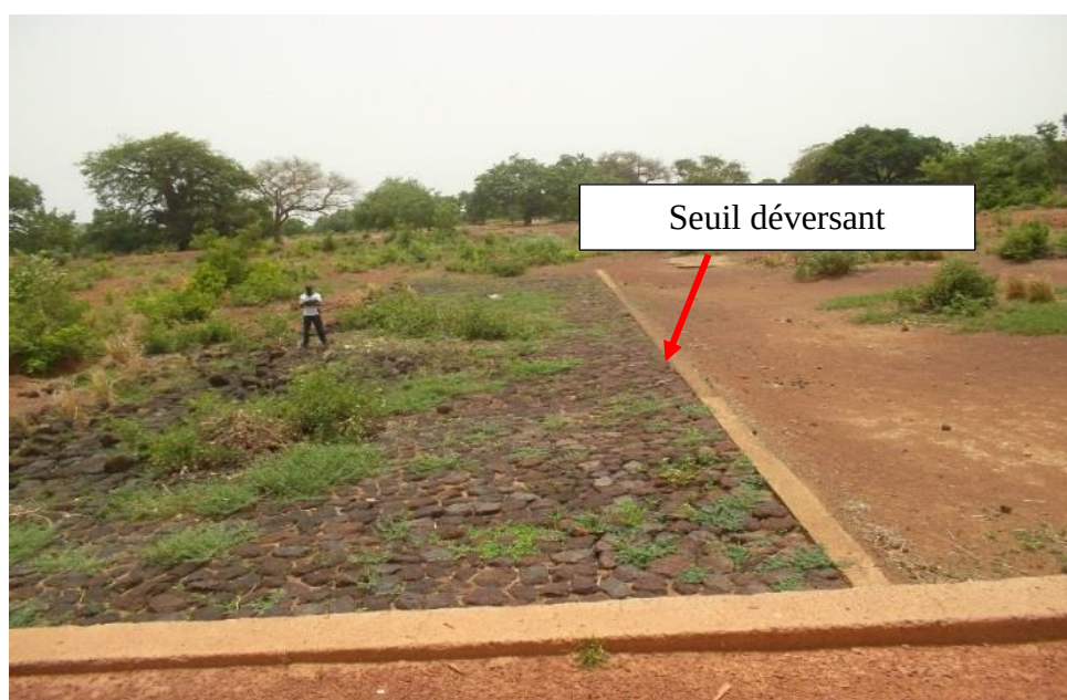
Photo 3 : Aperçu du seuil déversant (Source : AGETEER, 2017)
