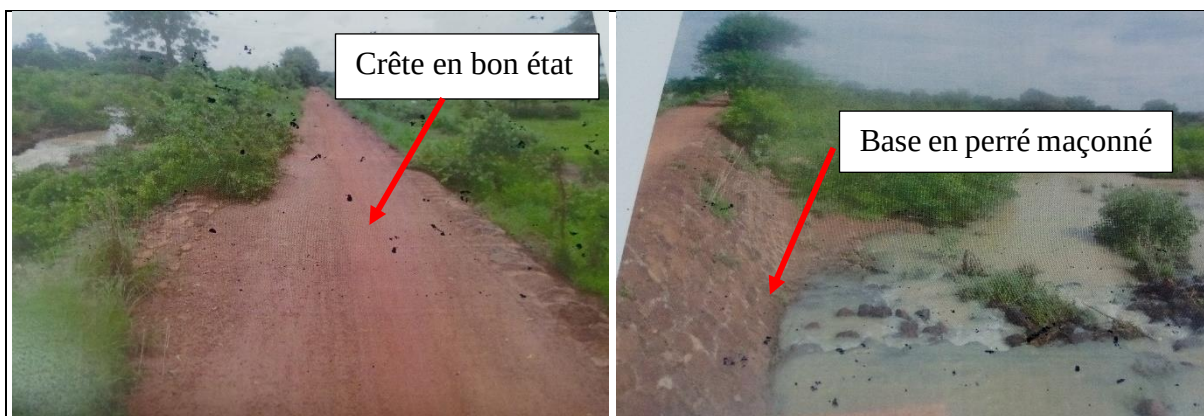
Photo 6 : Diguette de protection en rive gauche en bon état (Source : AGETEER, 2017)
