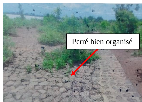
Photo 5 : Protection aval du seuil en rive droite (Source : AGETEER, 2017)
