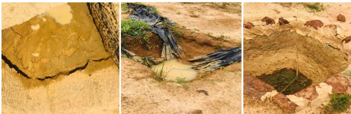
*Figure 2 : Durabilité argile-plastique-bitume constatée sur la plateforme d'irrigation*
