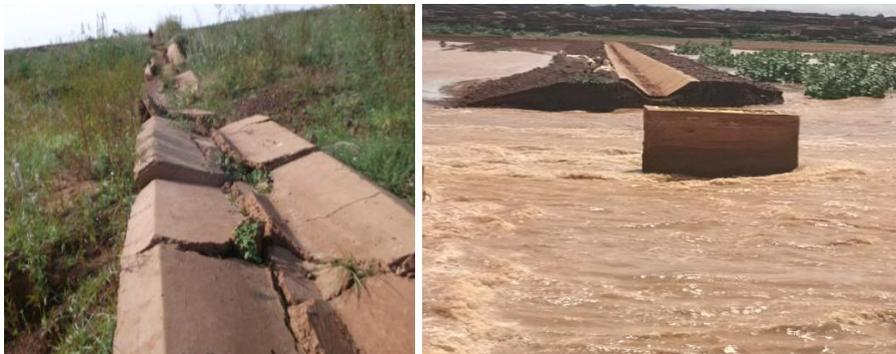
Figure 3 : dégradation des Canaux pour d'irrigation
