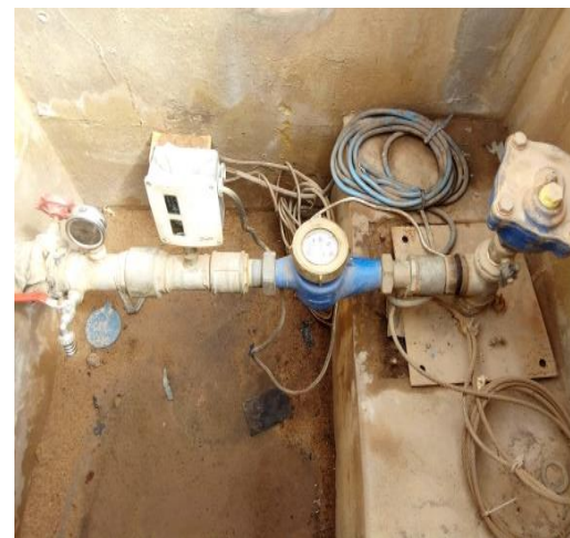
Figure 3: Tête de forage de KIENFANGUE
