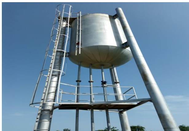
Figure 4: Château d'eau de KOMSILGA
