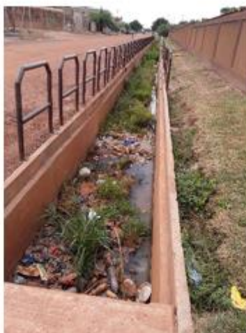
Photo 24 : Caniveaux du SPAQPO bouchés et mal entretenus
