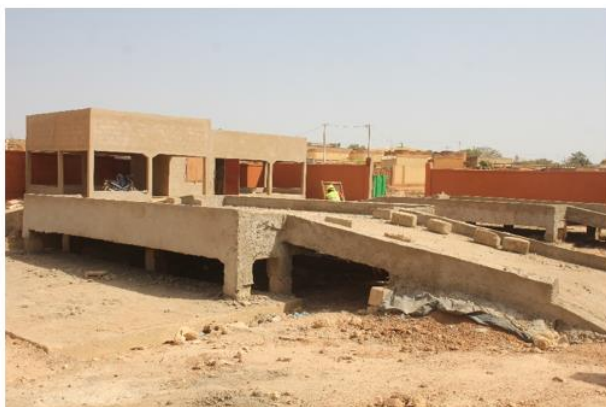
Photo 7: Centre de collecte et de tri en construction
