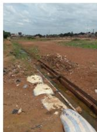
Photo 24 : Caniveaux du SPAQPO bouchés et mal entretenus
