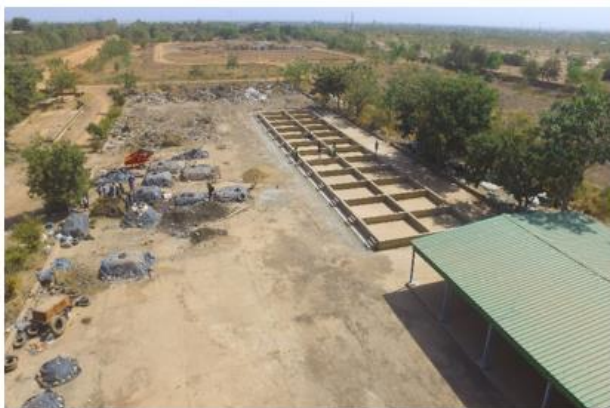
Photo 4 : Atelier de compostage du CTVD avec les aménagements du SPAQPO
