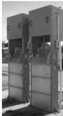
Figure 7:Présentation d'un dégrilleur
