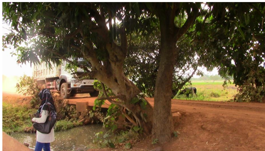
Figure 16 : Dalot fragilisé par les arbres
