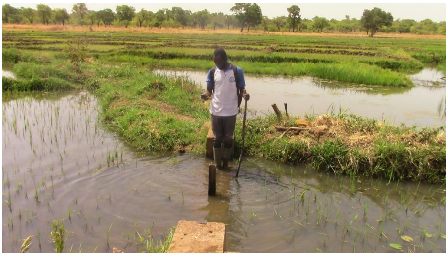
Figure 15 : Batardeau sur le canal principal
