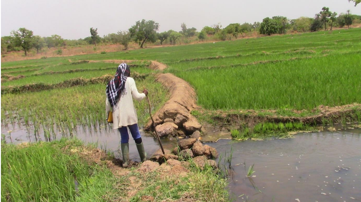
Figure 17 : Diguette à courbe de niveau détériorée
