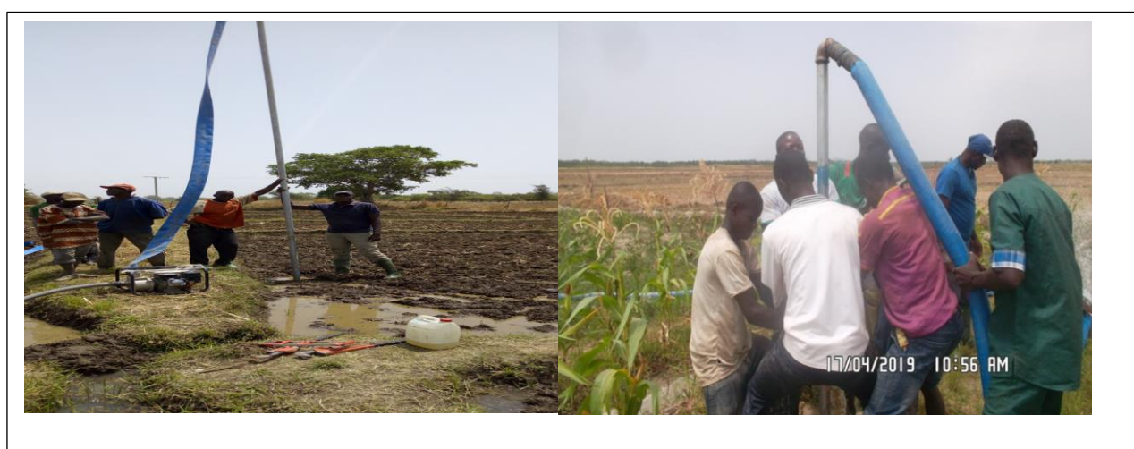
Photo 4:Enfoncement du Tube galvanisé
