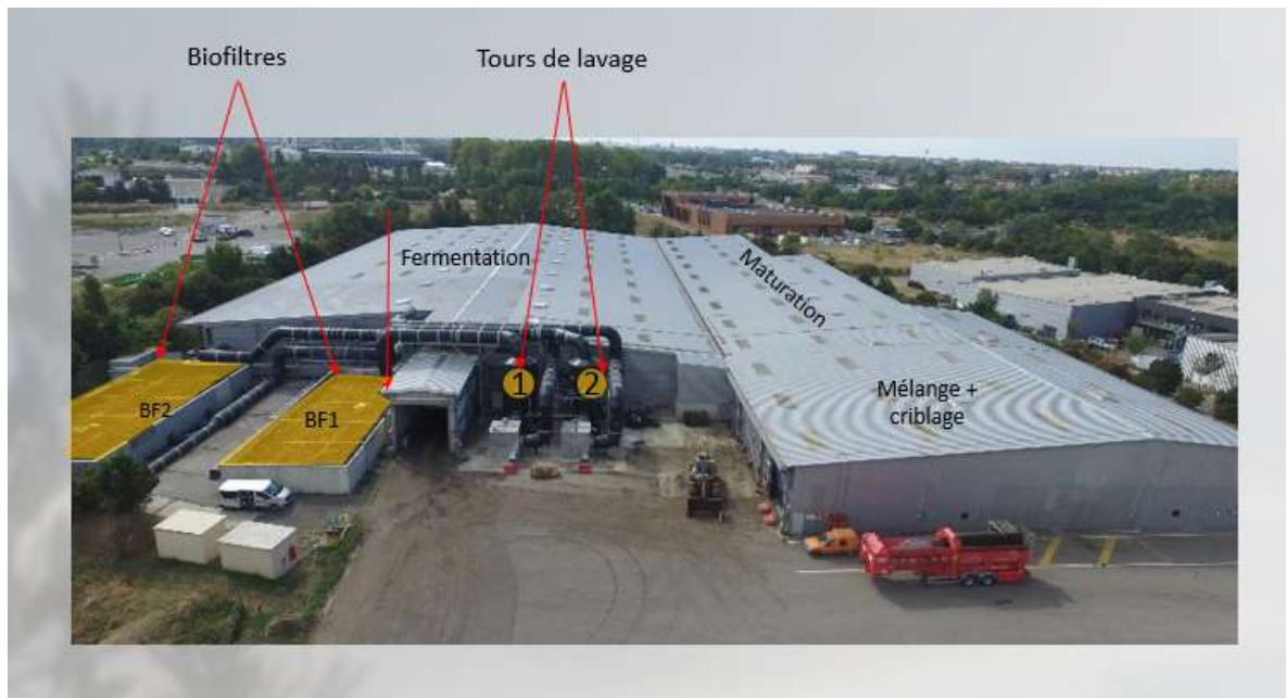
Figure 8 : Installations de compostage de boues en bâtiment
