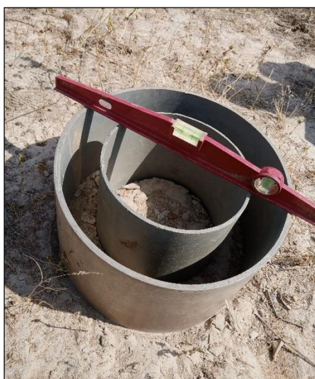
Figure 8 : Matériel pour les mesures d'infiltration
