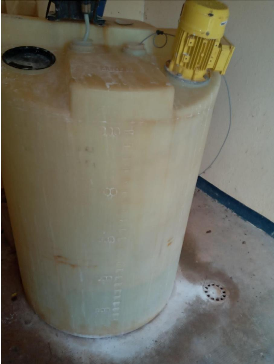
*Figure 17: Bac de 500l pour le mélange du chlore*
