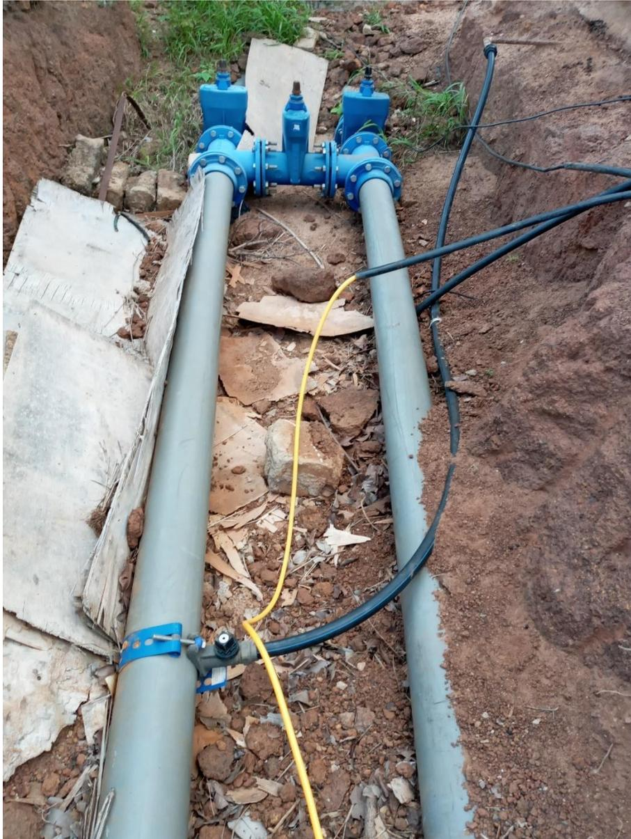
*Figure 16: Piquage sur la conduite principale de refoulement pour l'injection du chlore*
