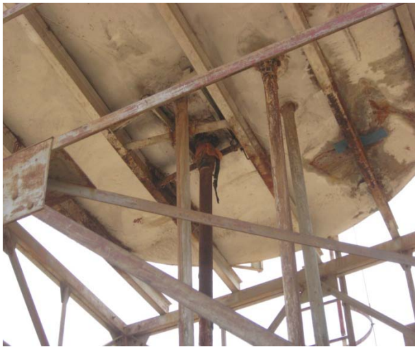
Photo 1 : dessous du château d'eau de Karofane
