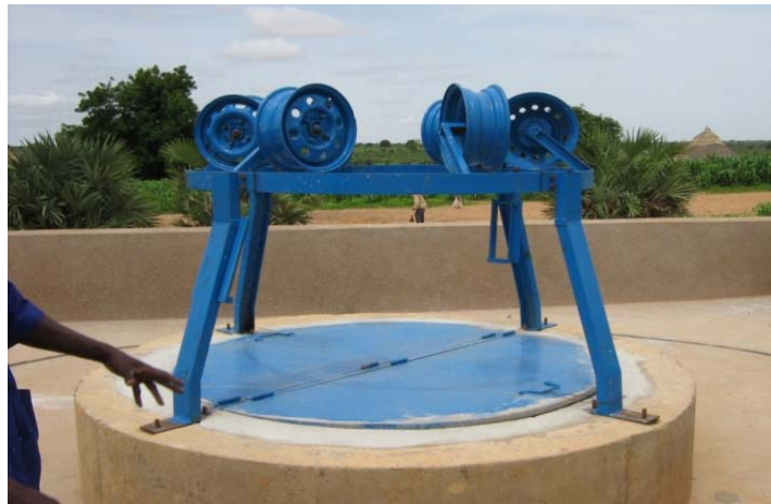
Photo n° 9: Modèle d'un puits cimenté bien aménagé
