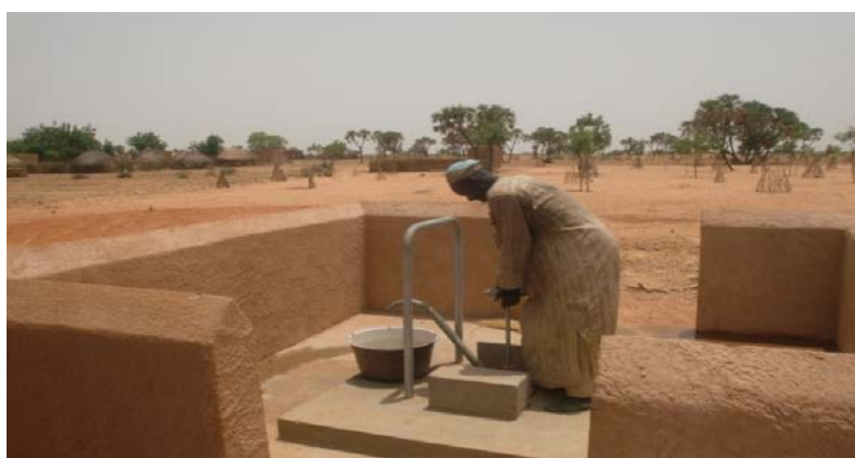
Photo n°8 :modèle d'aménagement de surface proposé au FPMH (dimension 3.5 x3.5 x 1m)
