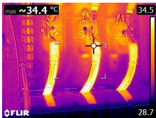
Figure 51: Thermographie des disjoncteurs Moteurs
