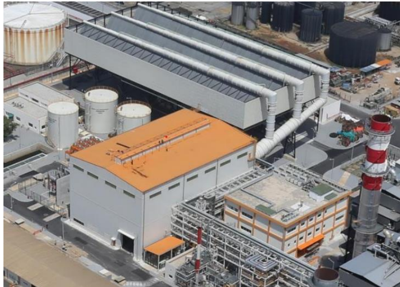
Figure 2: Vu aérien de la Turbine à vapeur
