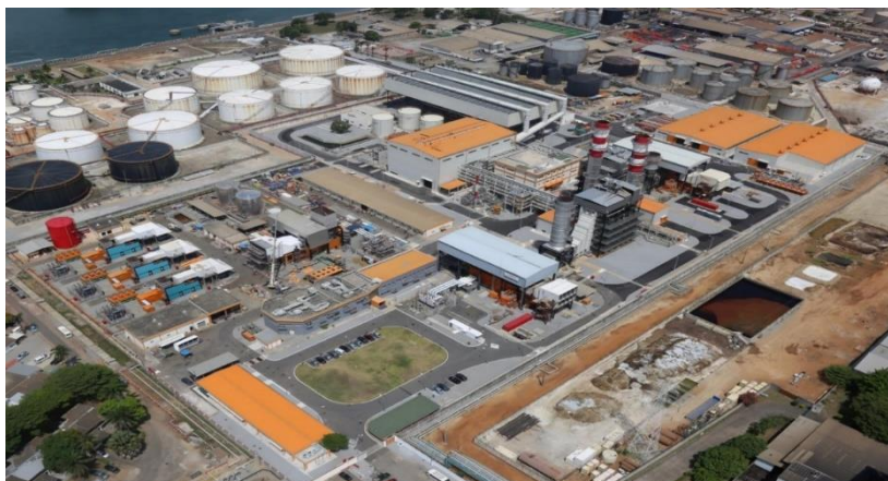
Figure 1: Vue aérienne de la centrale thermique
