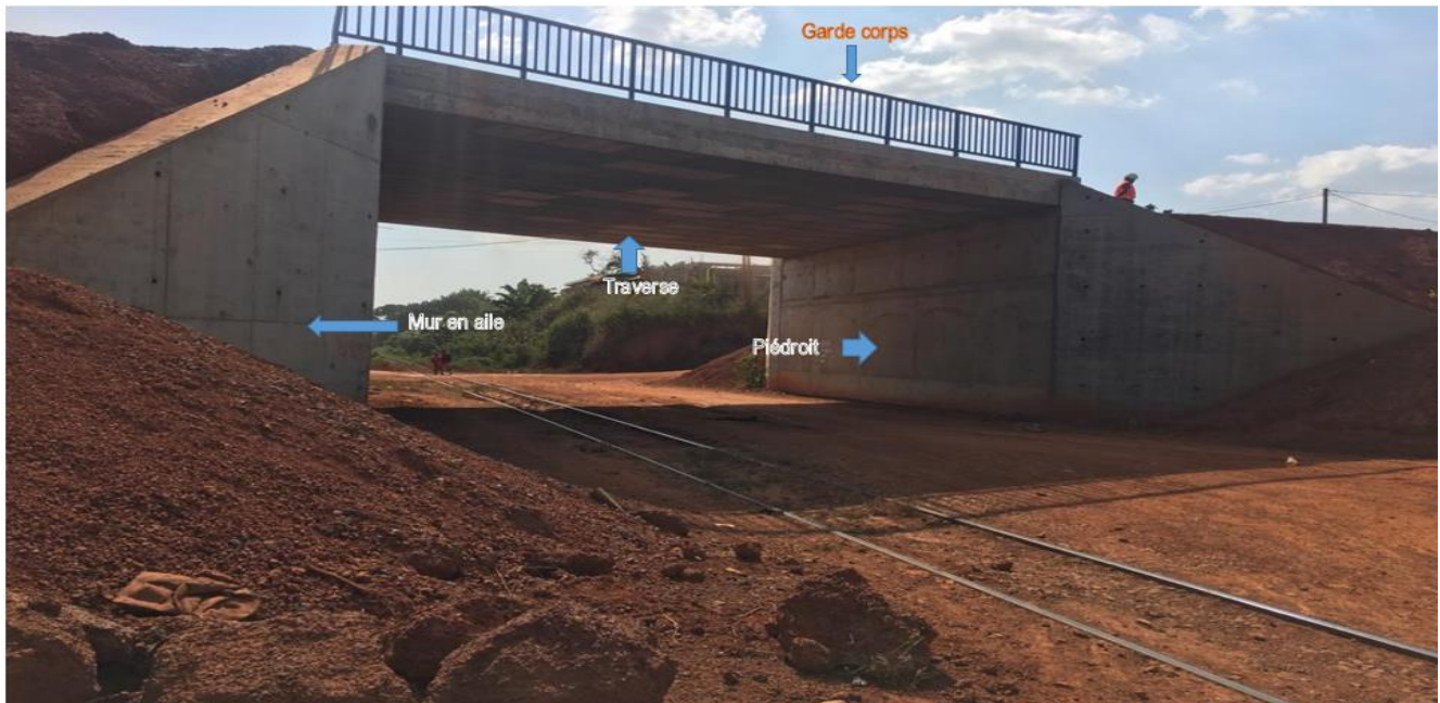
Figure 6 : portique avec murs en ailes
