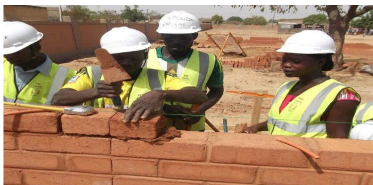
Figure 18 : aspect final et mise en œuvre des briques de terre comprimée
