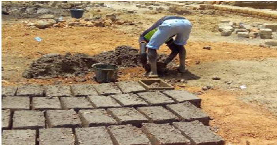
Figure 2 : Confection de briques d’adobe (Photo personnelle).
