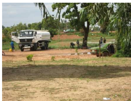
Lavage de véhicule de chantier dans le barrage
