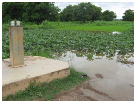
Un des forages du site (situé au bloc B) (Don de l'EIER)
