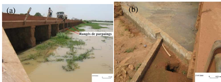
Photo III 2 : Modification du déversoir du barrage en avant (a) et en arrière (b)
