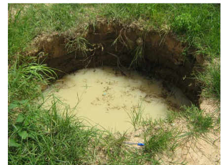
Effondrement d'un puits au bloc C
