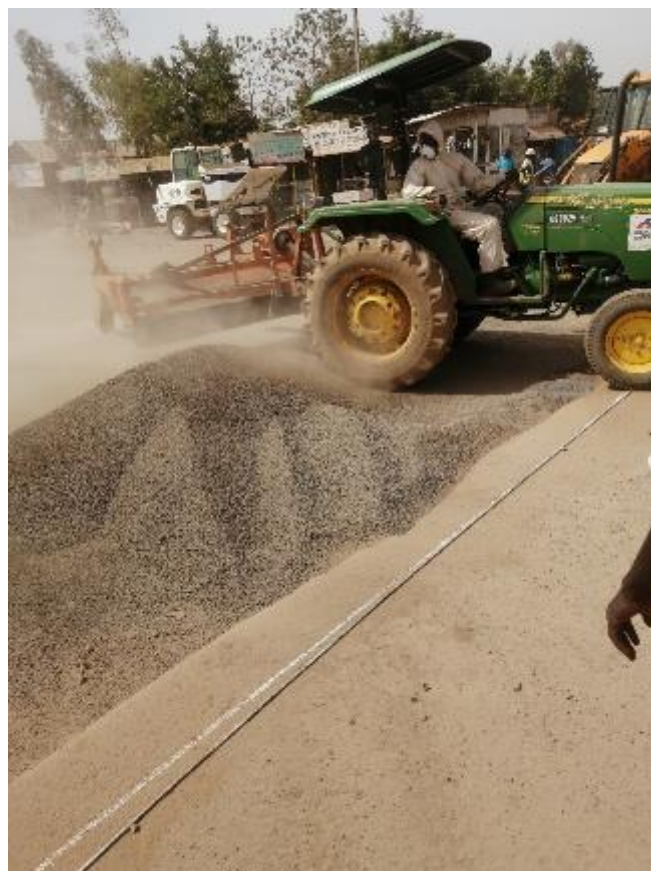
Photo 11 : Balayage du gravillonnage.
