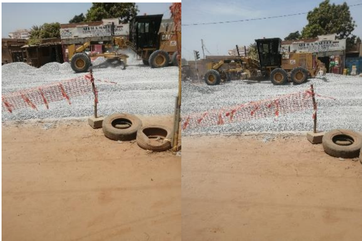
Photo 4 : Epannage de la GNT par la niveleuse.
