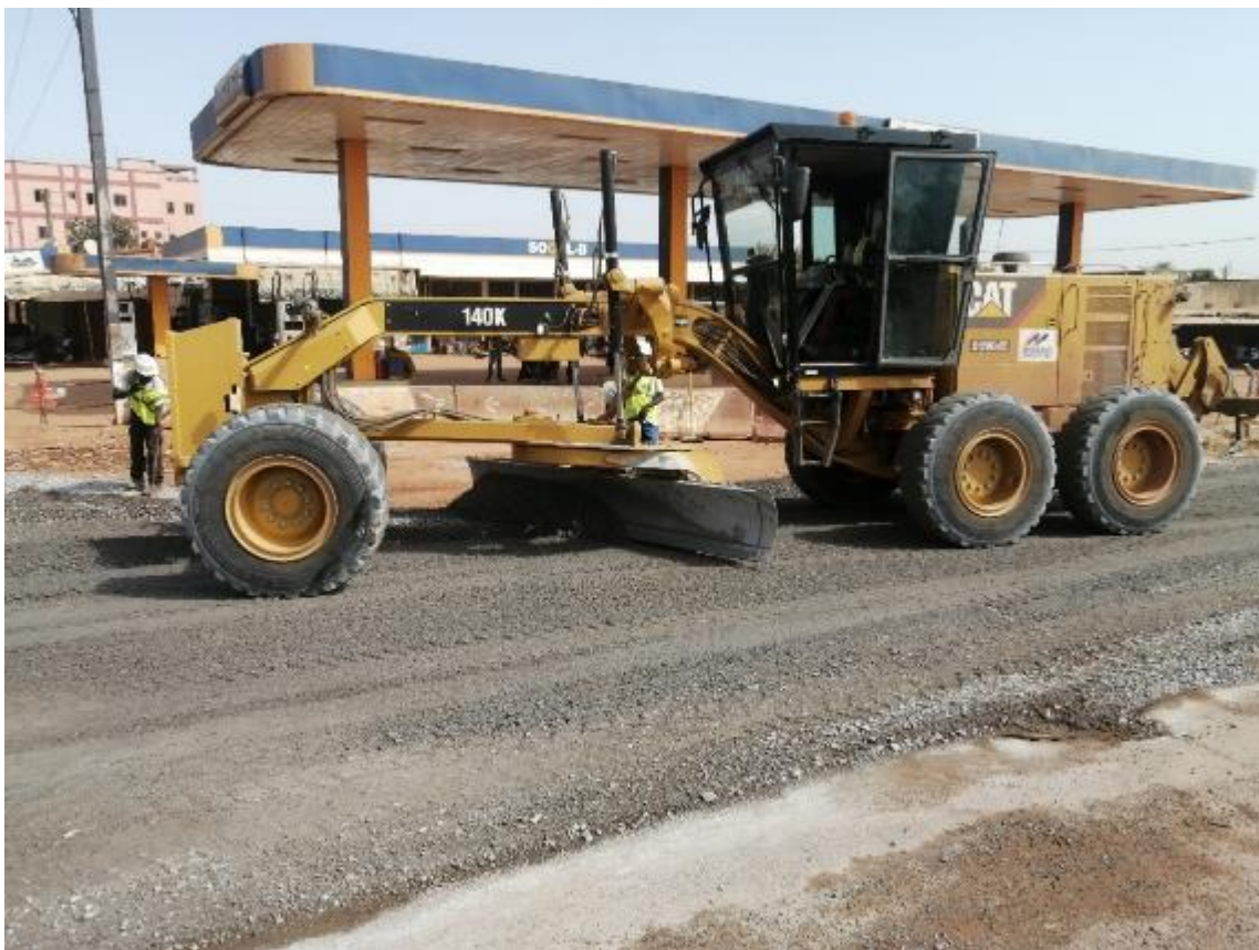
Photo 9 : Nivellement après implantation des piquets réglage.
