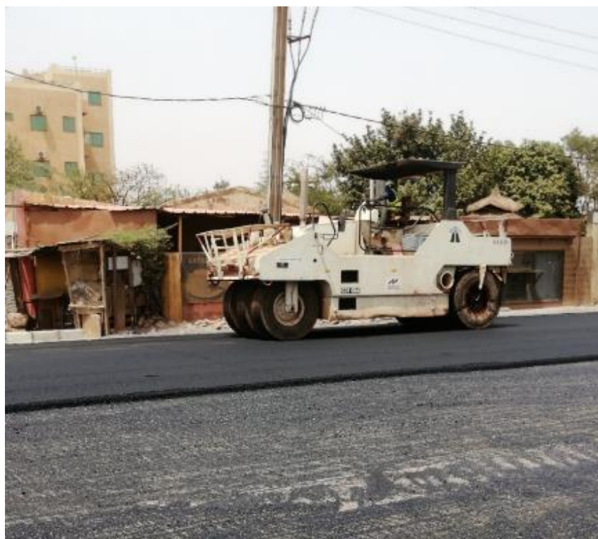
Photo 15 : Compactage de la couche de liaison (GB) par le compacteur a pneu.
