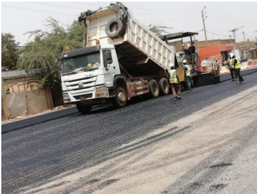
Photo 18 : Epannage de la Grave bitume (GB).
