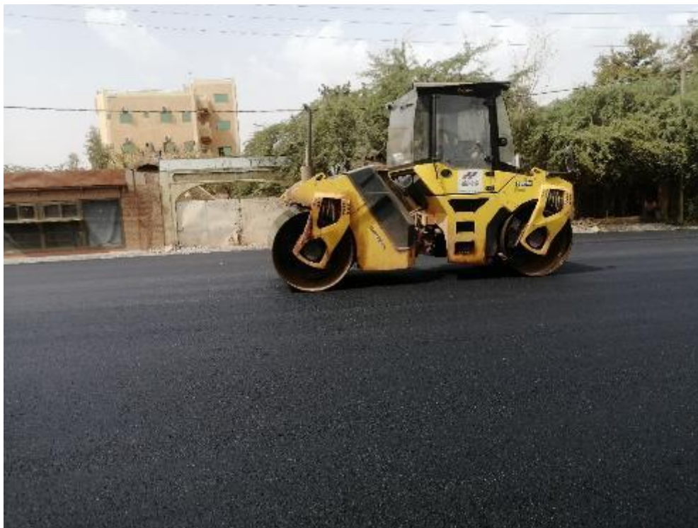
Photo 17 : Compactage de la couche de liaison (GB) par le compacteur a rouleau.
