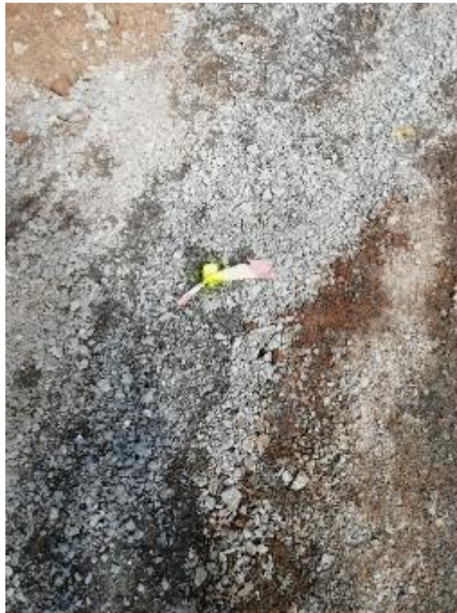
Photo 8 : Pique de réglage implanté par les opérateurs de topographie.
