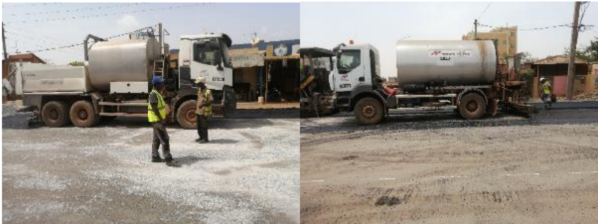
Photo 12 : Epandage de la couche d'accrochage.
