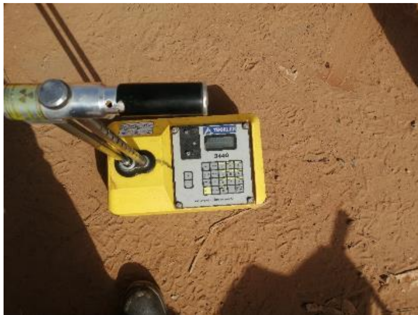
Photo 5 : Mesure de la teneur en eau et de la masse volumique du sol avec le Gamma densimètre.
