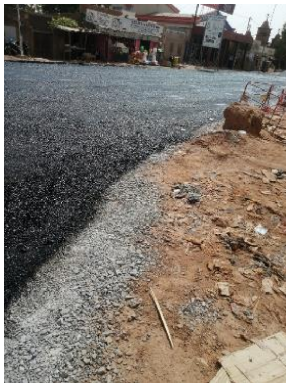
Photo 13 : Après la mise en place de la couche d'imprégnation.
