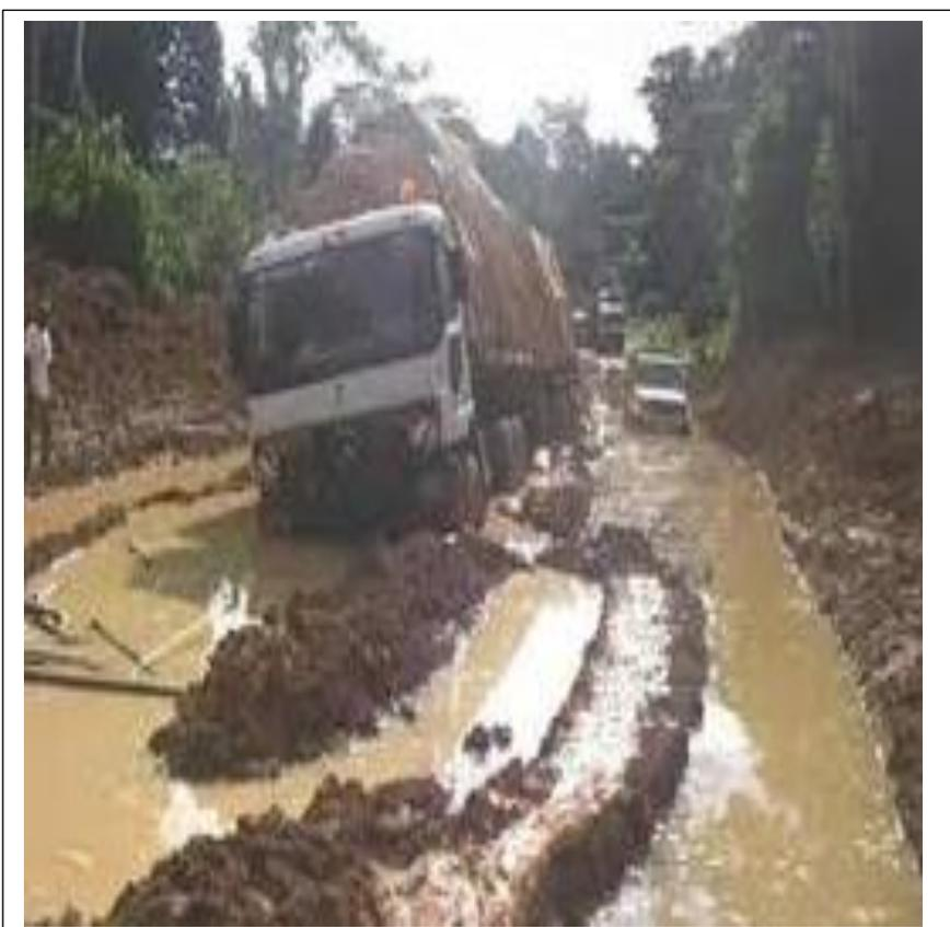
41: Exemple de point critique d'inondation des couches de chaussée sur le tronçon étudié
