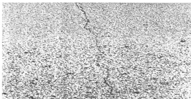
*Figure 3: Fissure : fissuration fine en pleine largeur. (LCPC, 1998)*
