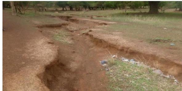
Photo 2 : Dégradation du pied de la digue
