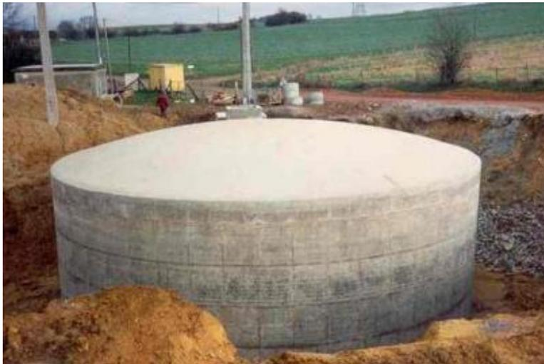
Figure 2: Réservoir enterré (Source : Cours Pr. Adamah MESSAN)
