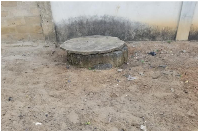
Puisard installé à la devanture de la concession à Minontin, Octobre 2020
