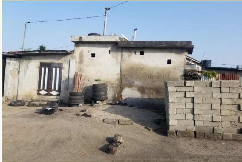
Figure 8: Construction des latrines sur les limites parcellaire à Gbodjè (Godomey)
