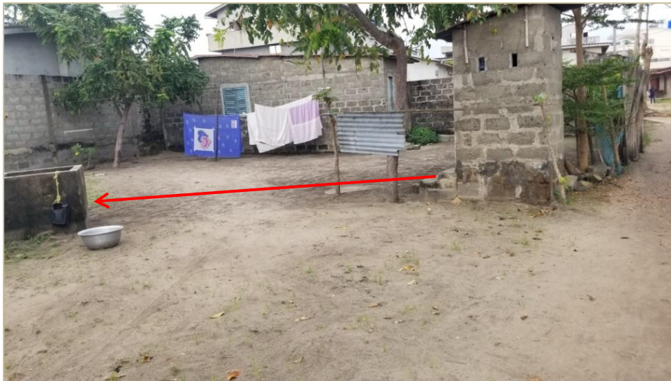
Figure 7: Proximité entre la fosse d'une latrine et un puits traditionnel
