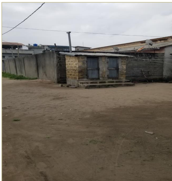
Latrine VIP surélevée à Gbodjè, Octobre 2020
