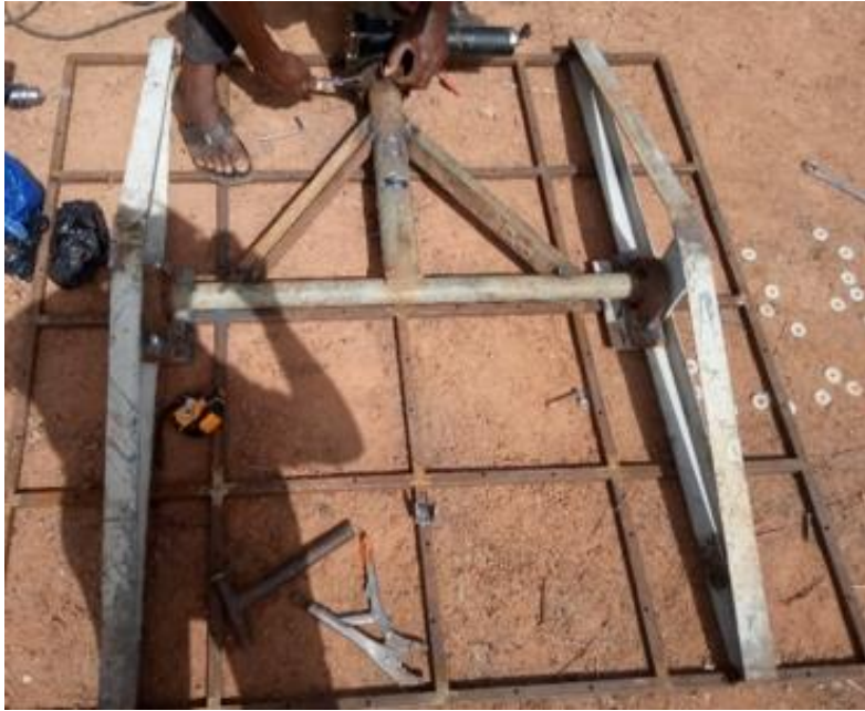
Figure 37. Montage de l'héliostat piédestal
