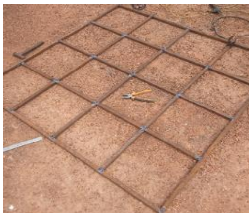
Figure 32. Réflecteur de l'héliostat piédestal
