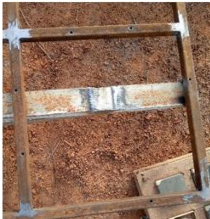
Figure 34. Perçage des trous de fixations de miroirs sur le réflecteur
