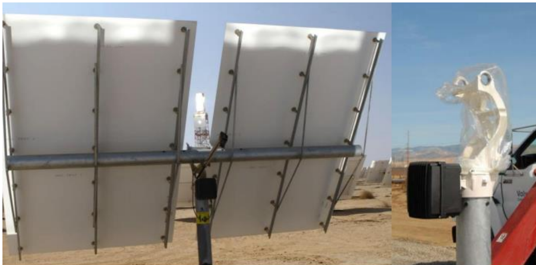
Figure 6. Héliostat LH2.2 (à gauche) et son support central (à droite) [8]
