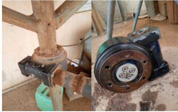
Figure 27. Démontage de la couronne d'orientation sur le piédestal
