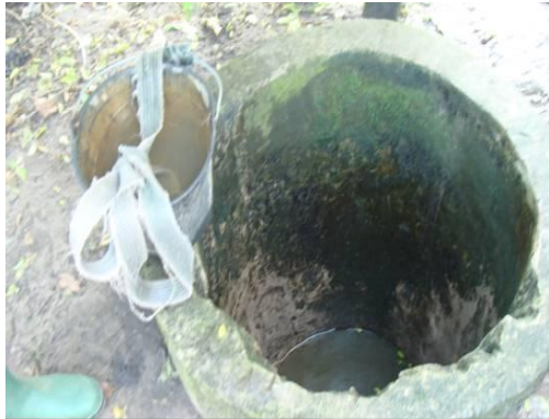
Photo 2: Puits non couvert à Cococodji
