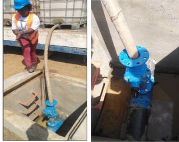
Figure 12: Remplissage de conduite DN200
