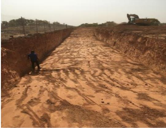
Figure III-1: réalisation des fouilles et compactage
