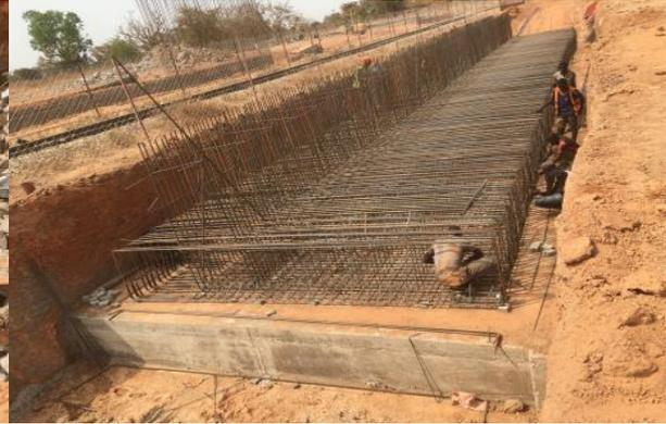
Figure III-4: ferrailage de la semelle
