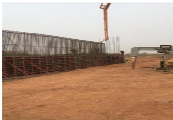
Figure III-9: coulage du béton
