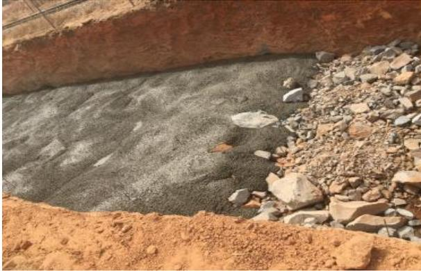
Figure III-3: réalisation du gros béton
