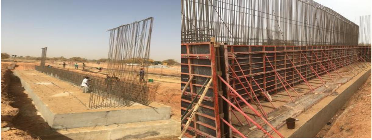
Figure III-7 : ferraillage de la culée
