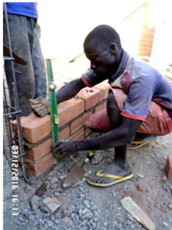
**Photo 20** : La construction d'un mur en BTC par un maçon : Source : ZOUNGRANA, enquête de terrain, 2016
