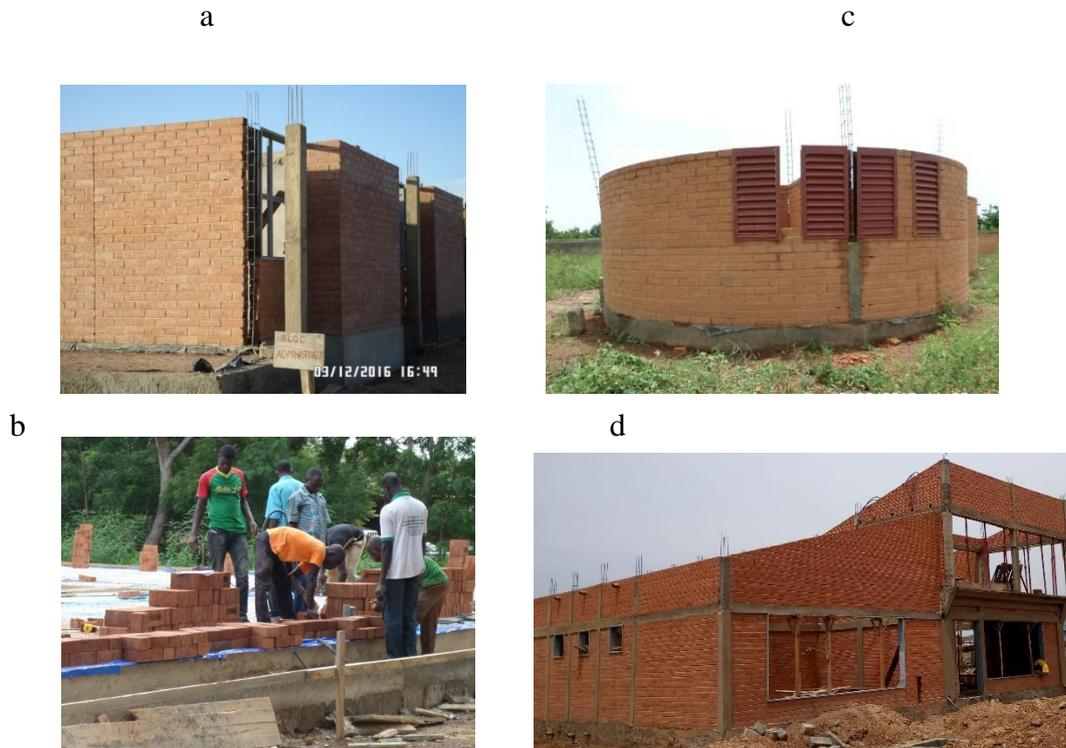
**Photo 2 :** Les chantiers de construction en BTC à Ouagadougou. Source : ZOUNGRANA, enquête de terrain, 2016, 2017, 2018,2021
