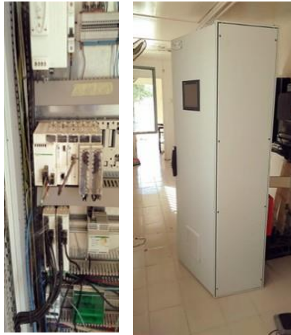
Figure 14 : Armoire de gestion de l'énergie
