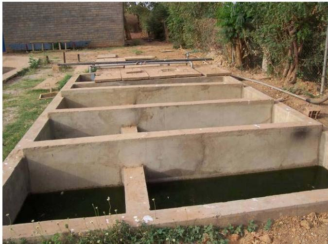
Figure 5: Filtre sur sable et sur gravier
