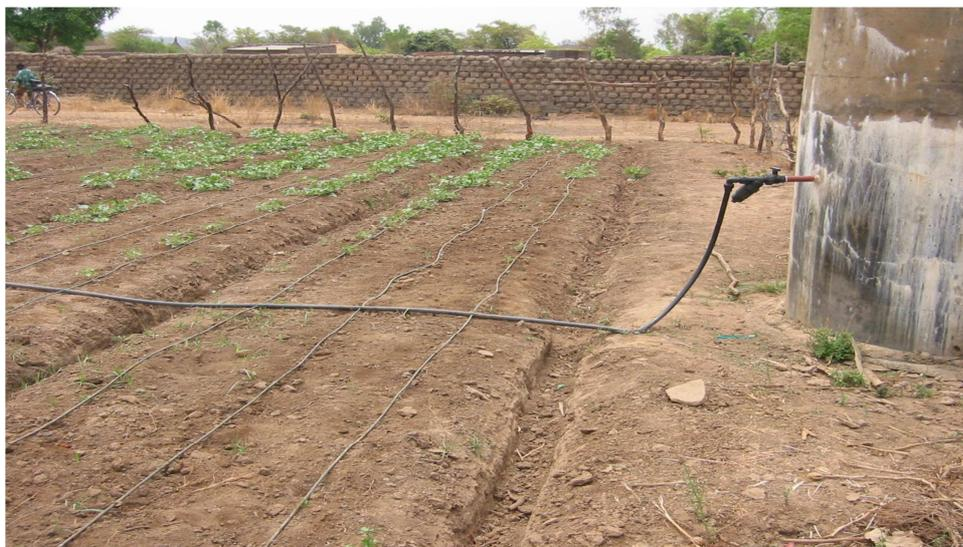
Photo 5. Système d'irrigation goutte à goutte basse pression type JPA, (ARSA/PNUD, 2007)
