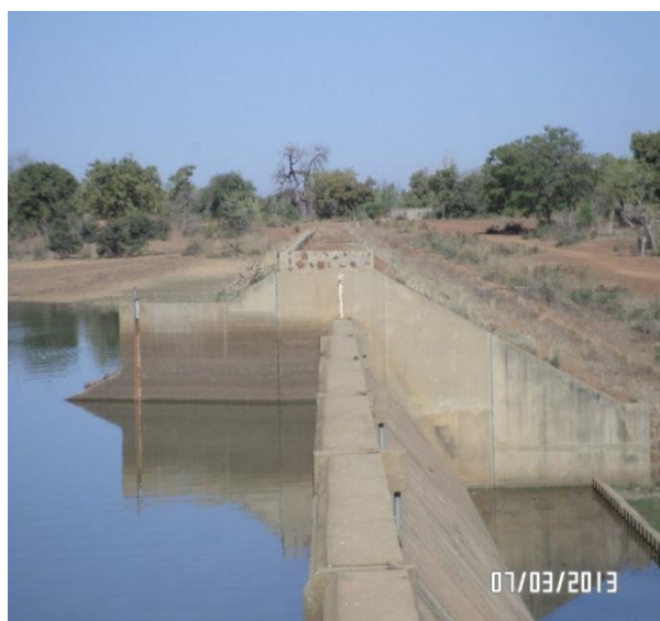
Figure 9: Limnimètre au niveau du déversoir
