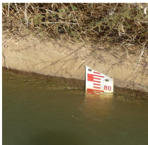
Figure 10: Echelle au niveau de la prise du barrage
