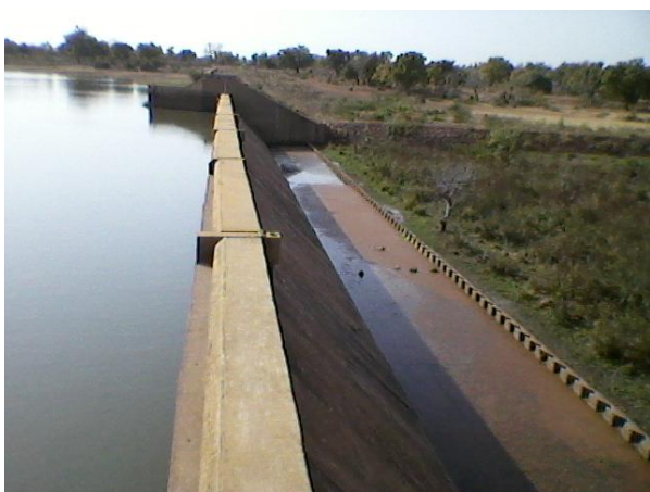
Figure 4: Déversoir rehaussé par des blocs fusibles
