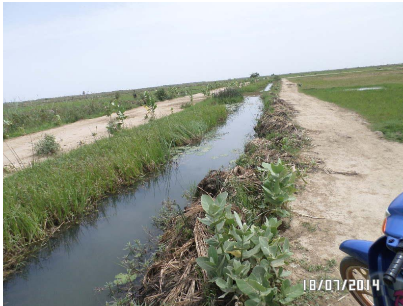
Figure 11 : Arroseur G3/3 à Fouabougou, Gruber; Source : KOUAKOU et KOUMARE, visite de terrain, Juillet 2014
