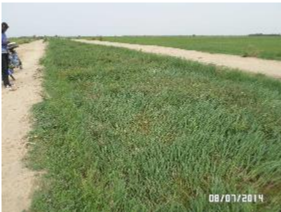
Figure 20 : Image du drain KLO ; Source : KOUAKOU et KOUMARE, visite de terrain 2014
