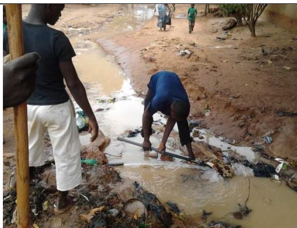
**Figure 4: Collage d'un tuyau pvc sur un branchement en PEHD**
