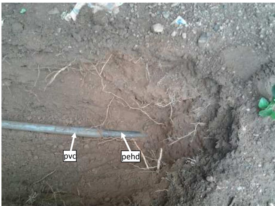
Figure 8 : sondage réalisé sur un branchement connaissant des fuites répétitives
