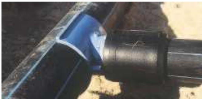
Elles se posent sur la canalisation principale. Le serrage est réalisé de façon autonome ou avec l'aide d'un positionneur. Elles sont équipées d'un fil de résistance intégré à la périphérie de la zone de perçage. Cette technique de dérivation permet de garantir l'étanchéité même en cas de légers mouvements des canalisations.
