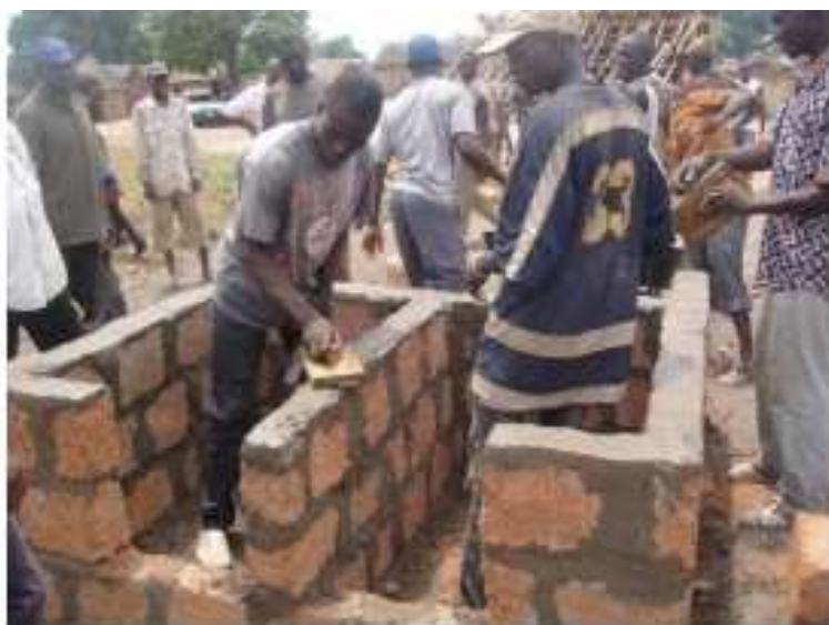
Figure 8-a: Montage d'une Fosse
