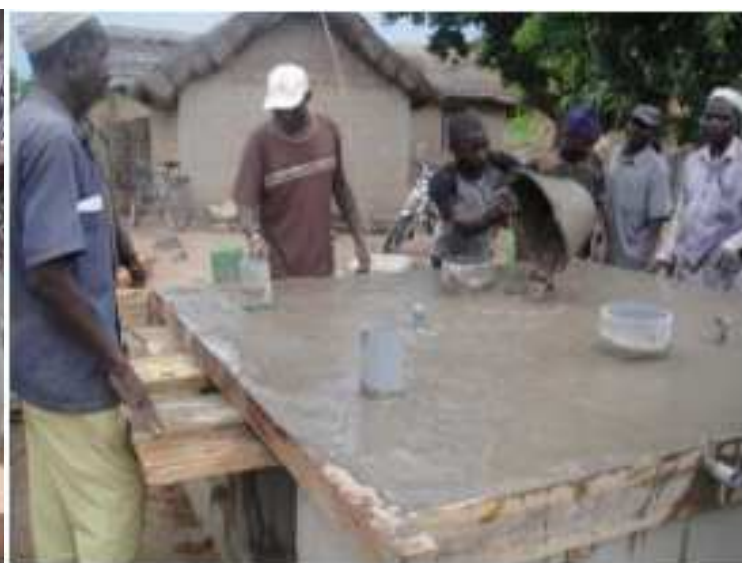
Figure 8-b: Coulage d'une Dalle
