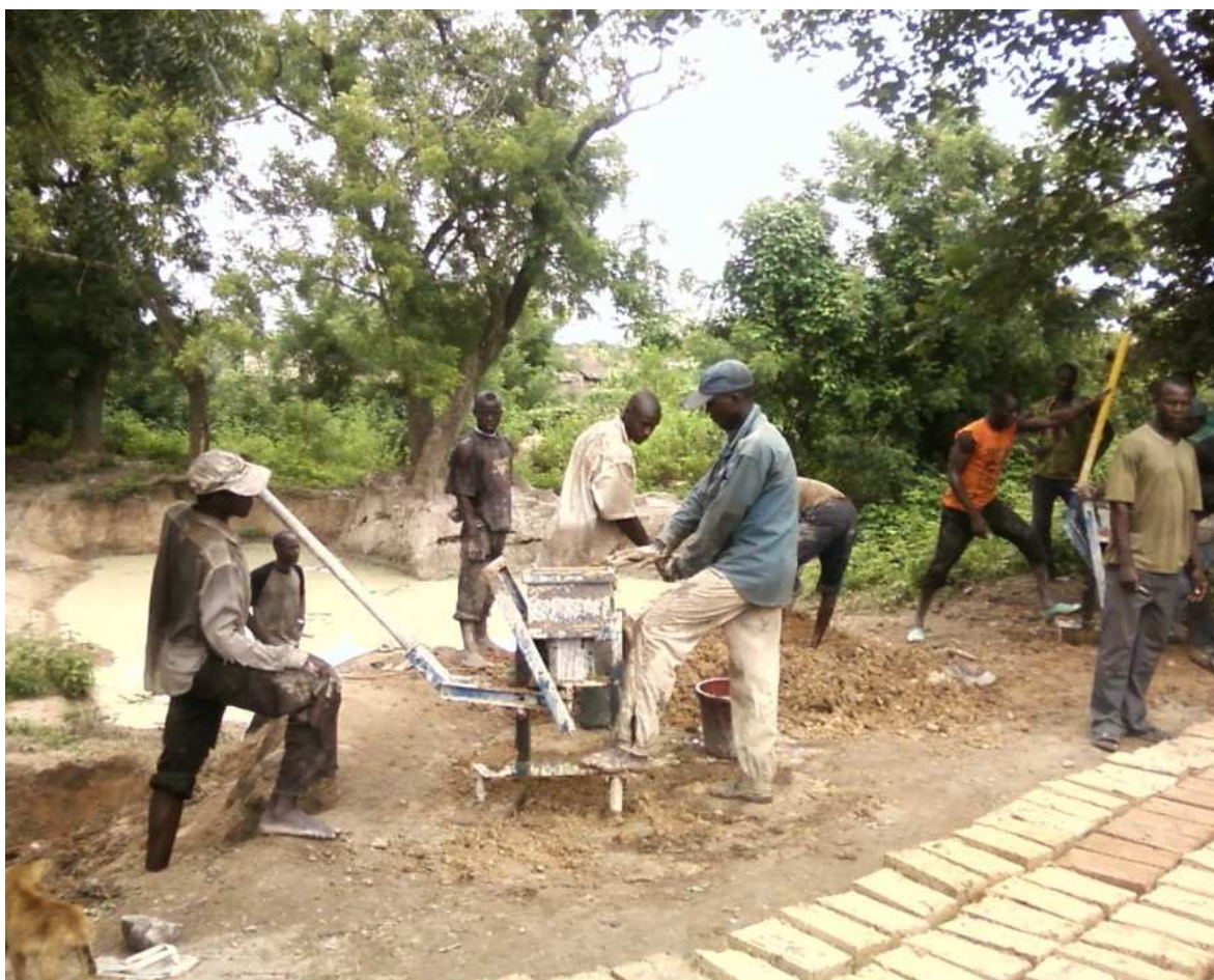
Figure 6: Mobilisation des briques par la communauté à Lamékaha3
