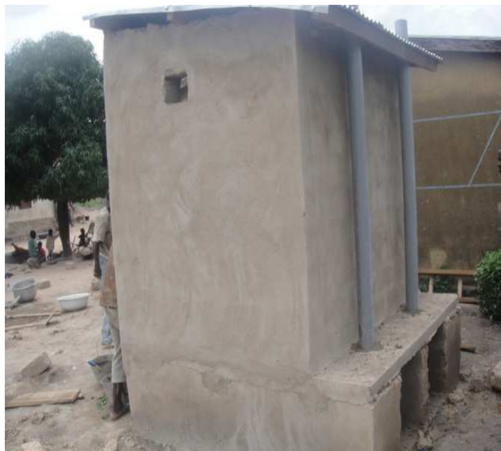
Figure9-b: Superstructure (vue de côté)
