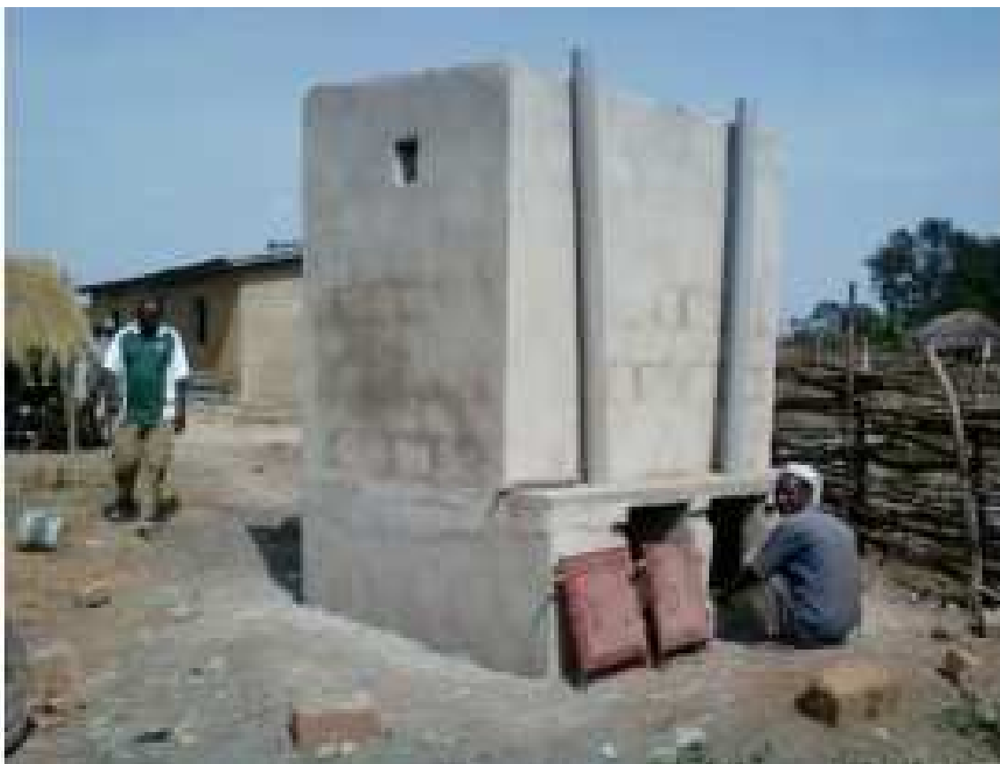
Figure10:Pose de tuyaux de ventilation et de plaques chauffantes
