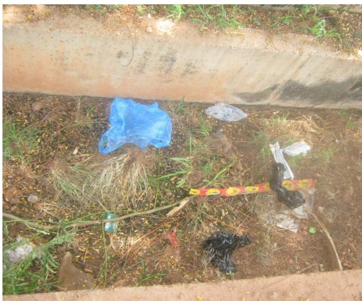
**Photo 2: Présence de quelques déchets solides et de sable dans le collecteur C3**
