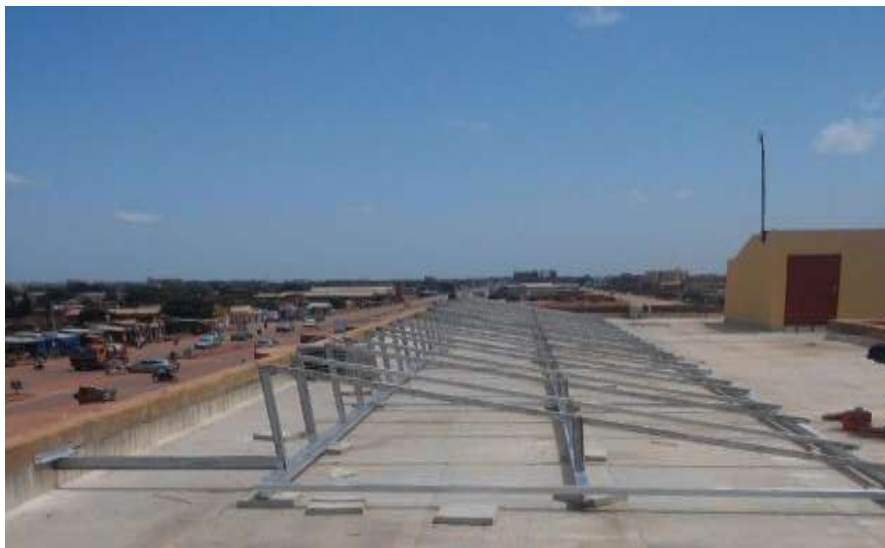
Figure 13 : structure pour pose des modules PV
