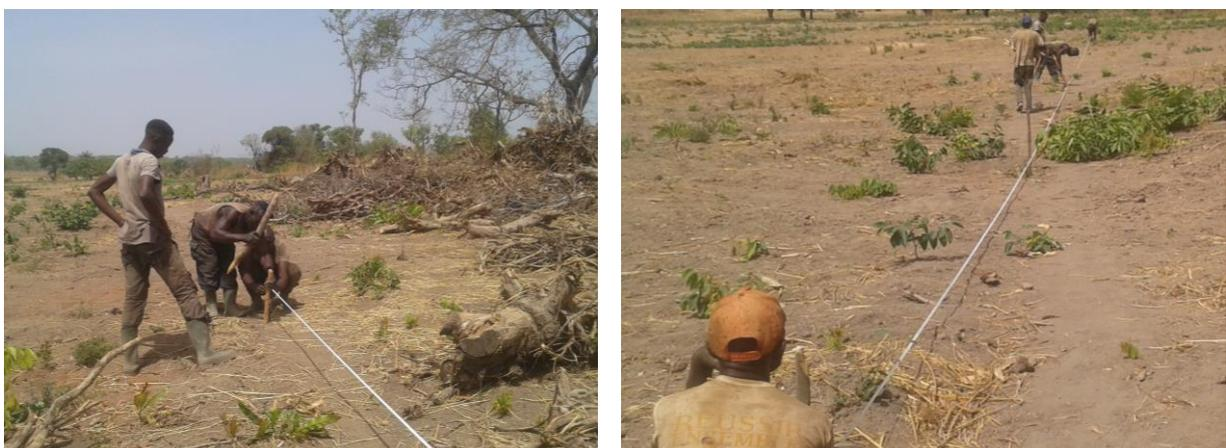
Figure 18: Implantation du réseau d'irrigation (Lassologo)
