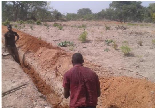
Figure 19: Exécution des fouilles pour la pose des conduites
