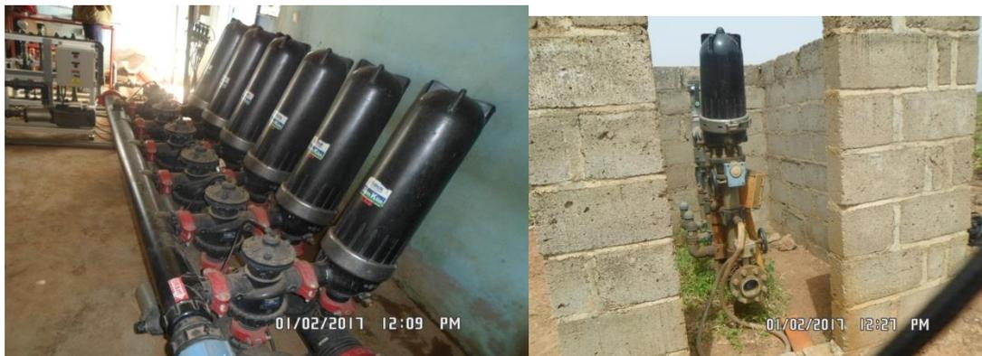
Figure 10: Filtre à disque sur B3/66
