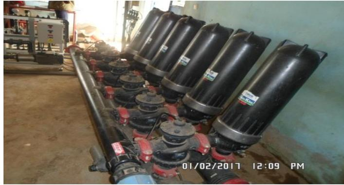
*Figure 6: Filtration à disque.*
