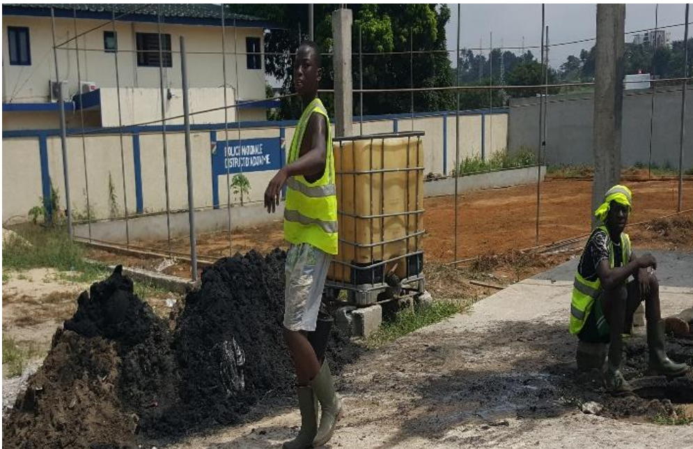
Figure 14: Opération de curage manuel
