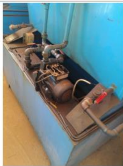
Cuves journalières nécessitant un nettoyage intérieur et extérieur
