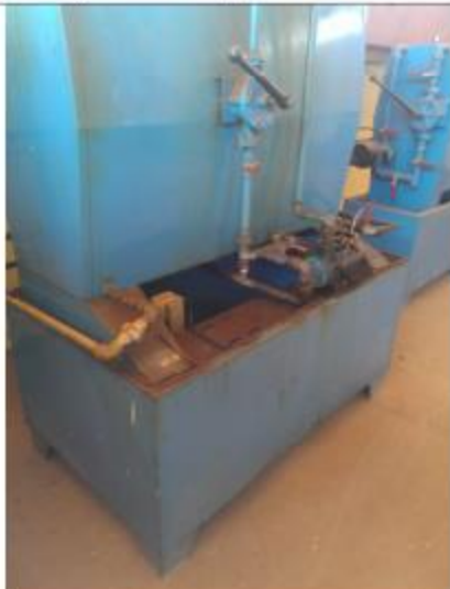
Cuves journalières nécessitant un nettoyage intérieur et extérieur
