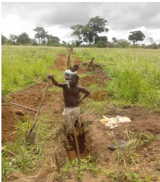
Figure 9: Réalisation des tranchées et pose de conduites
