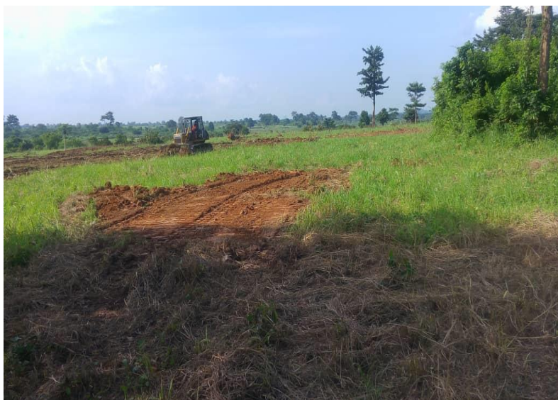
Figure 7: Lors des travaux de défrichage
