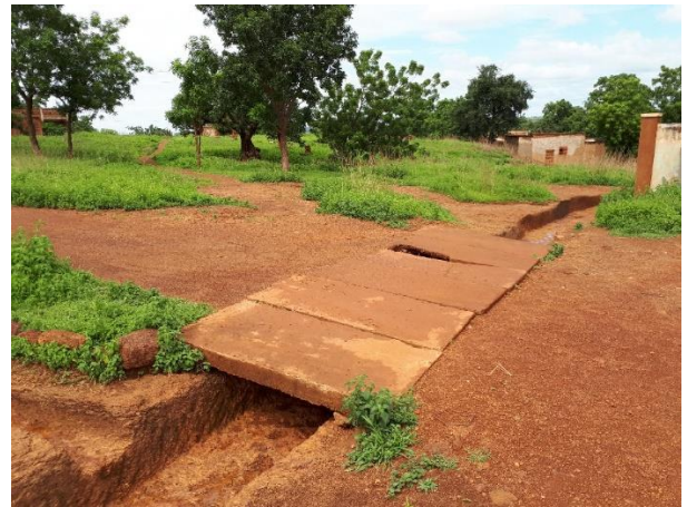
Photo A 17 : Assainissement pluvial de Dano
