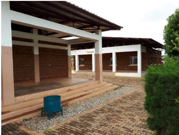
Photo A 14 : Ecole primaire à Dano
