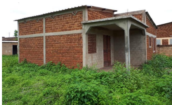
Photo A 13 : Villa F2 à Dano
