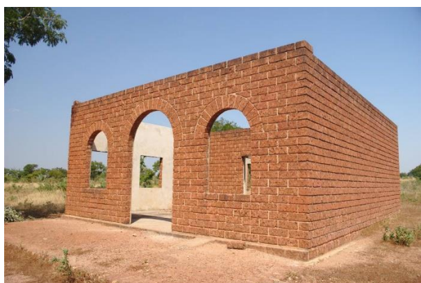
Photo A 2 : Construction d'une maison modèle effectuée par KAMAPIERRE en 2008
