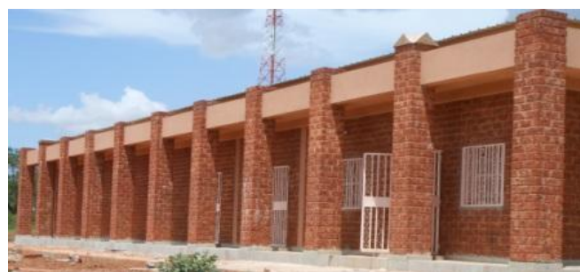
Photo A 4 : Hôpital construction effectuée par KAMAPIERRE en 2009
