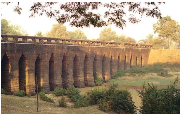
Photo A 8: Pont angkorien en latérite à Kampung Kdei, large de 16 m et toujours en service
