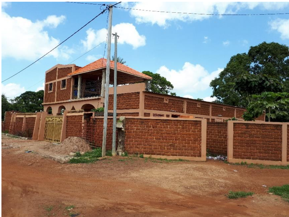
Photo A 18 : Villa R+1 à Dano
