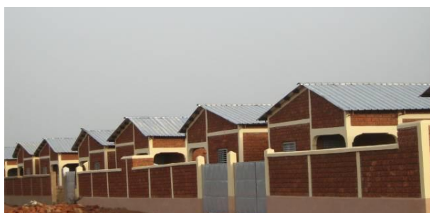
Photo A 1: Vue partielle des 30 logements sociaux en BLT construit à Dédougou
