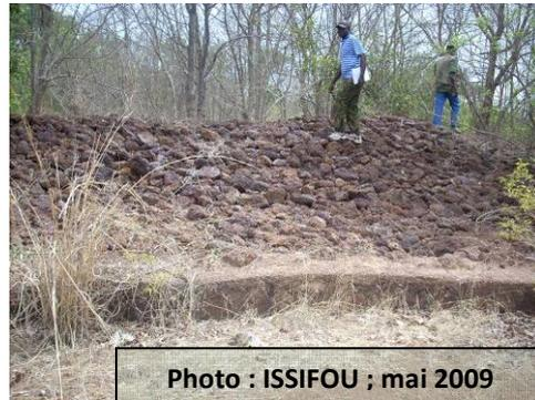
Photo n°6 : Digue endommagée du barrage Petit Balé
