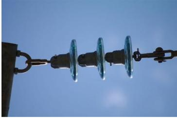
**Figure 5.a :** Chaîne de trois isolateurs haute tension
