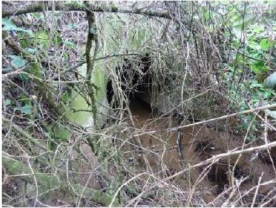
*Figure 14: Buse envasée (source : ASF, 2020)*
