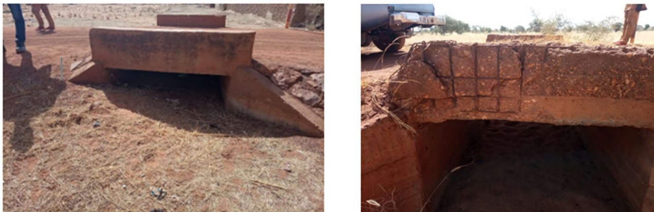
Figure 4 : Etat actuel des ouvrages hydrauliques de la route Saouga-Essakane
