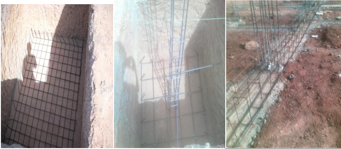
Mise en œuvre du ferrailage et pose des armatures
