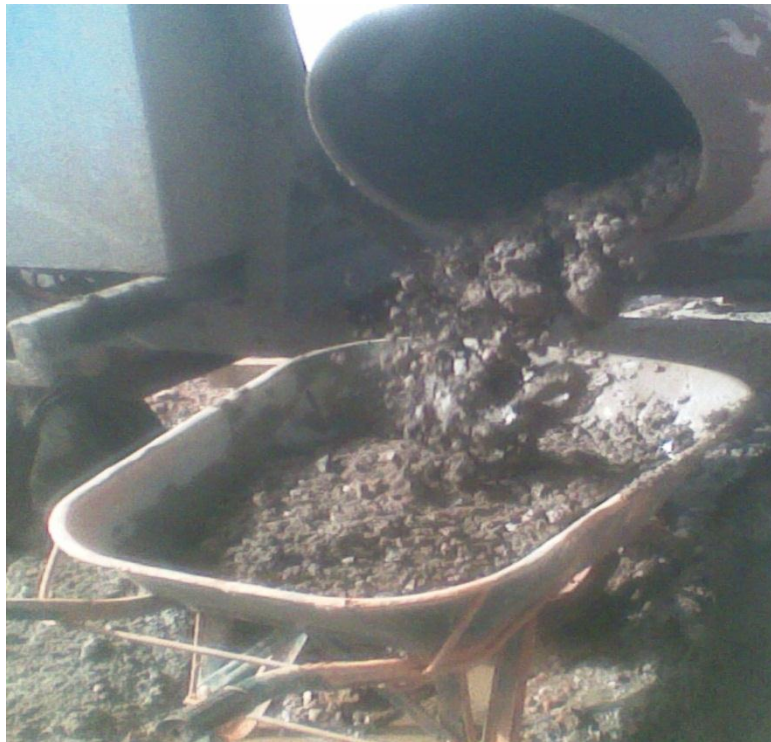
Bétonnière se vidant de sa gâchée dans une brouette
