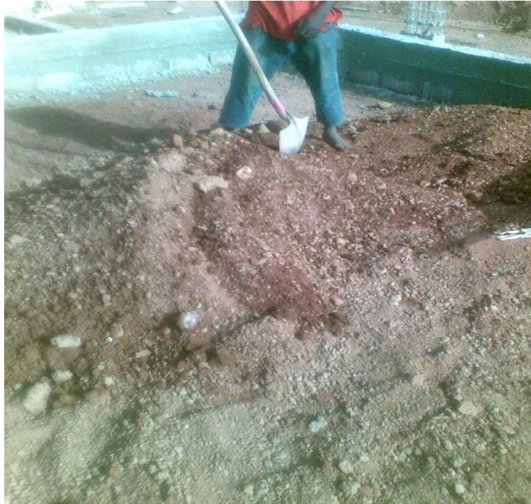
Manœuvre étalant le remblai avant compactage
