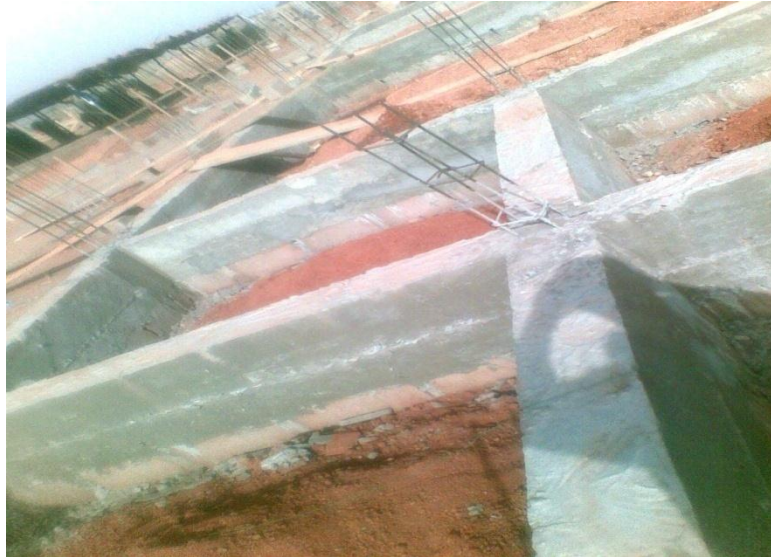
Longrine après décoffrage
